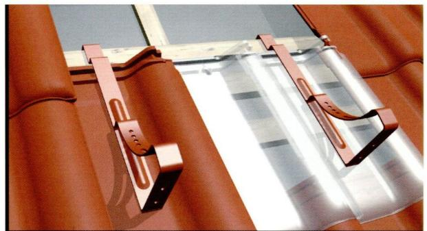
Priskrutkovať jednodielnu konzolu (typu L) k skôr namotovanej hornej montážnej late.
